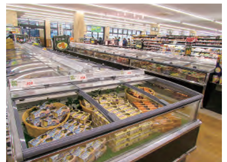
蓋付平冷ケースとリーチイン冷ケースで省エネを図りつつ売場を比較的広く取っている冷蔵・アイス売場
